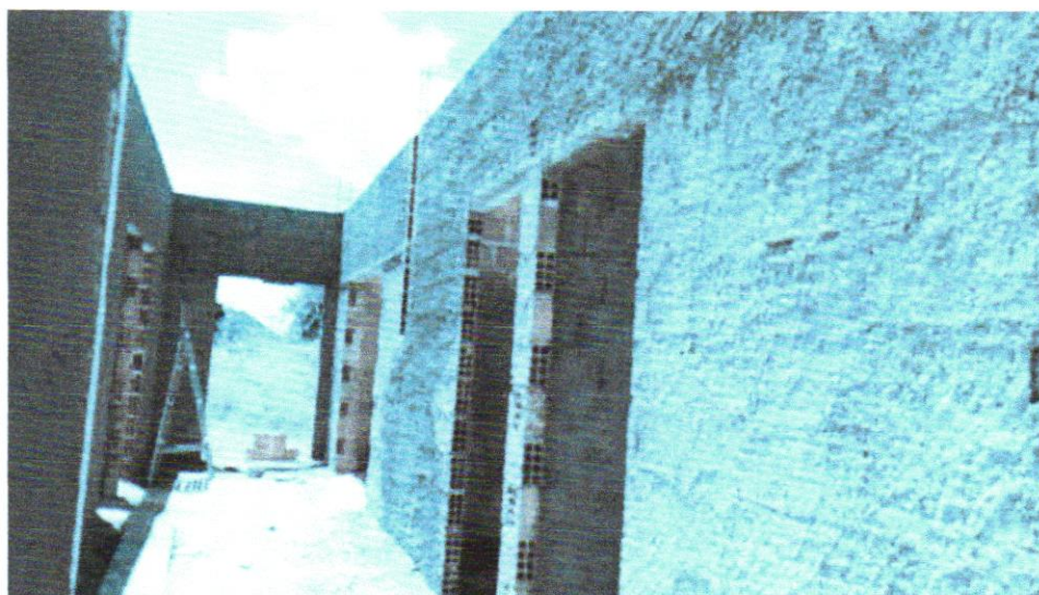
FOTO 04 – CHAPISCO APLICADO EM ALVENARIAS E ESTRUTURAS DE CONCRETO INTERNAS, COM COLHER DE PEDREIRO. ARGAMASSA TRAÇO 1:3 COM PREPARO EM BETONEIRA 400L. AF_06/2014
