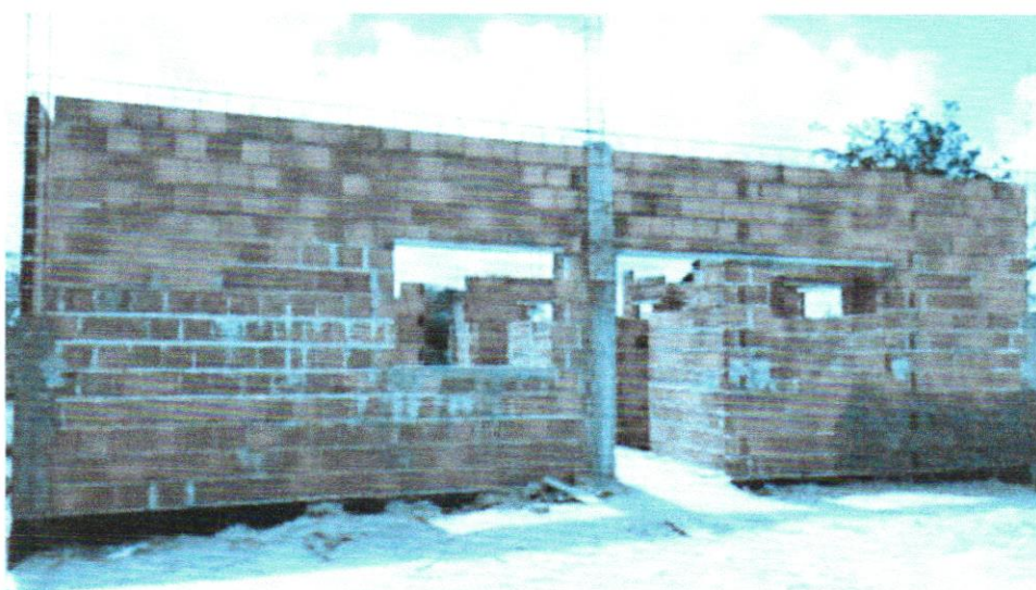
Foto 10 - VERGA PRÉ-MOLDADA PARA JANELAS COM ATÉ 1,5 M DE VÃO
