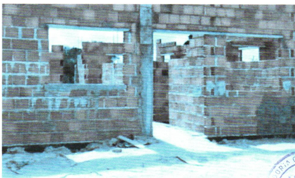
Foto 10 - VERGA PRÉ-MOLDADA PARA JANELAS COM ATÉ 1,5 M DE VÃO
